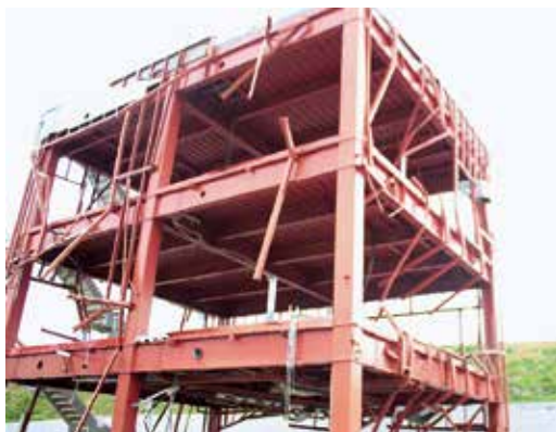
南三陸町防災対策庁舎跡
